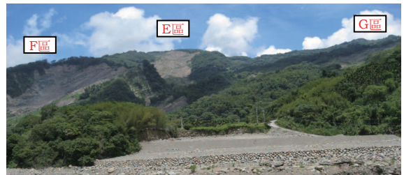
圖 9 E、F 與 G 區崩塌照片，F 與 G 區崩場地主要受層面控制
