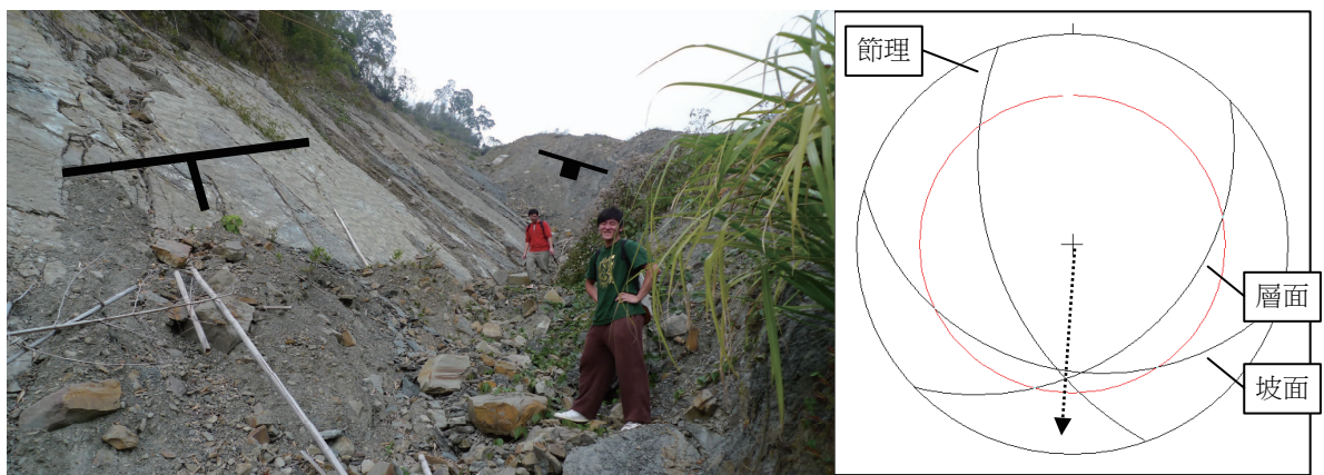
圖 6 (a) A 區楔型破壞之野外照片；(b) A 區崩塌立體投影分析；此一崩塌區層面、節理面交線與地面相當一致，顯示該區地形主要受岩層面與節理面交線之楔型滑動所控制
